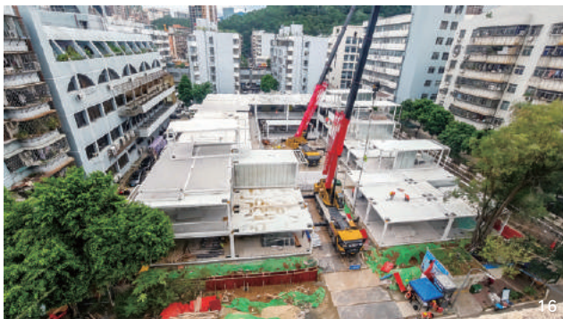
16. 翠北实验小学校园施工过程
