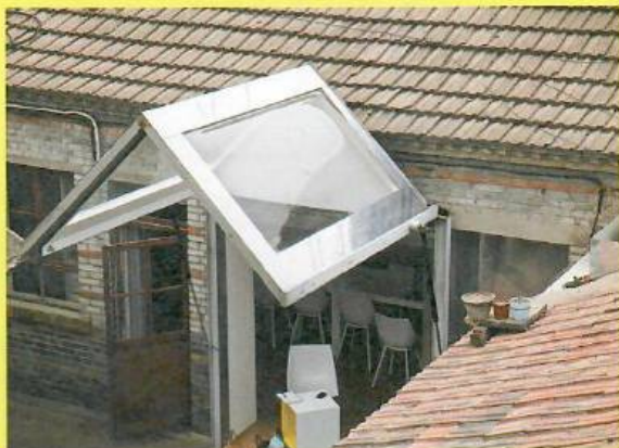
プラグインによるリノベーションでこの部屋も2000円程度作られている。扉だけは特注90度開けることで屋根になりデッキスペースのようになる。
