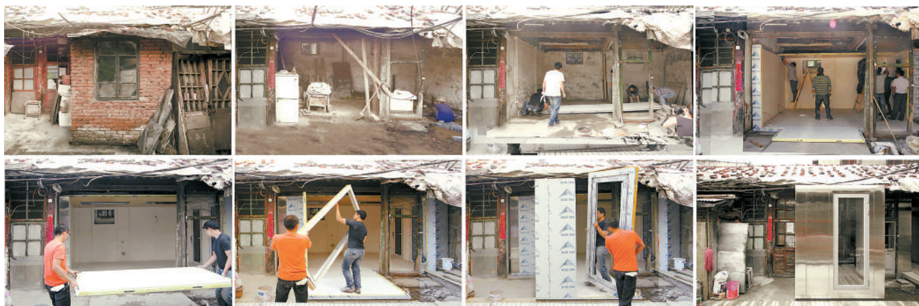
杨梅竹斜街72号院改造过程。
