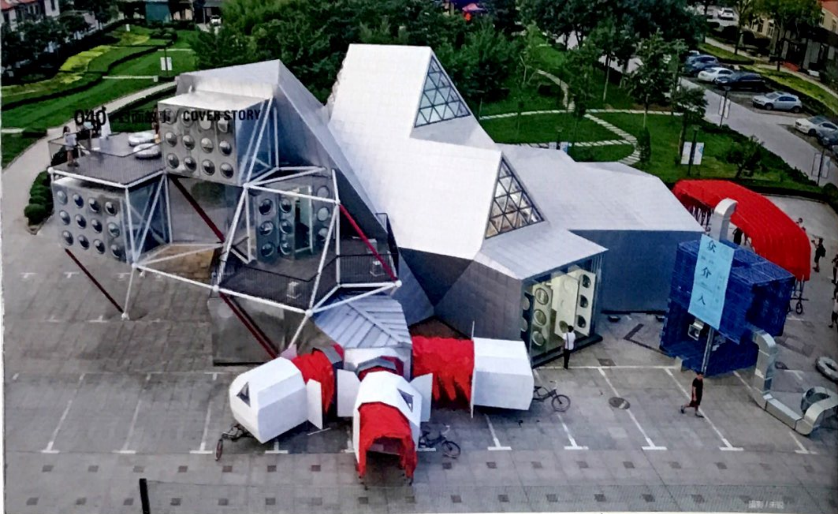
“广仁众空间”是众建筑在烟台的一片滨海历史街区中插入的预制建筑，由预制插件组装建成。通过对材料的拆装自由伸展来适应需求的变化。
