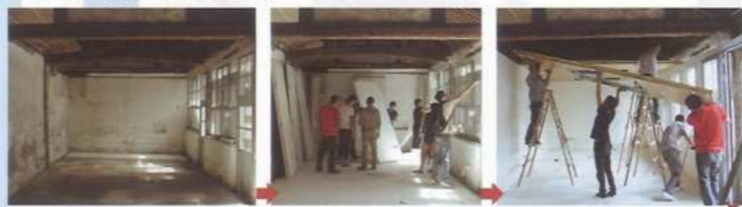
北屋辦公室內合院組裝過程
