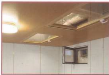
透過天窗，可看見舊建築木結構屋頂。
